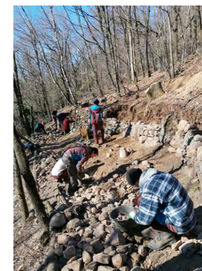
Civilistes en action dans la reconstruction d'un mur en pierre sèche. Vico Morcote, Ticino. Photo : Andrea Guidotti.
