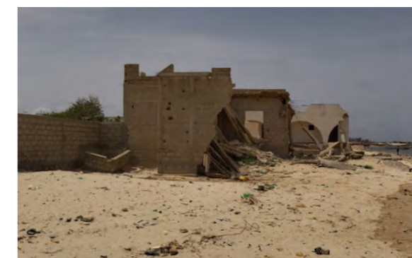
Érosion côtière. St. Louis, Sénégal. Loic Bruening 2021
