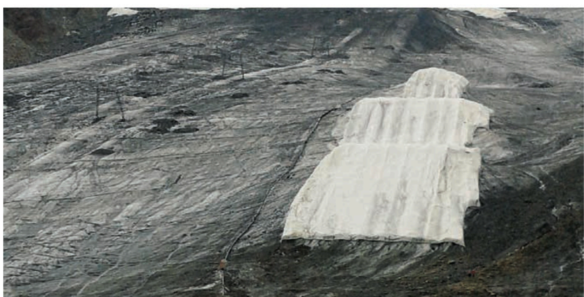
Abb.2: Abdeckung eines Schneedepots mit Vlies auf einem Gwletscher. Bei genauem betrachten sind die Überlappungen der Vliese durch vertikale Linien, die weniger abgeschmolzen sind ersichtlich.
